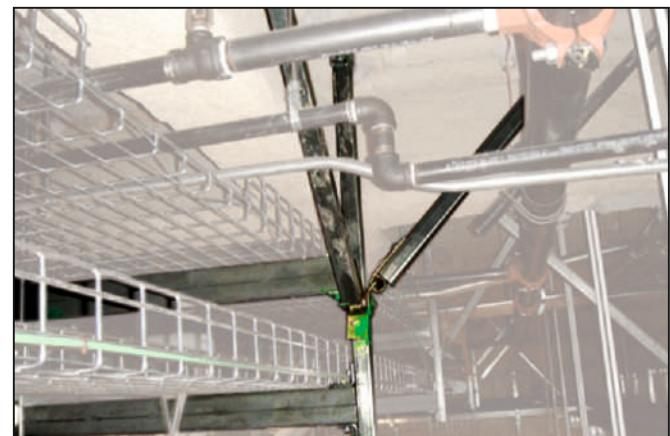
**Şekil 3.7, 3.8, 3.9, 3.10 Elektrik Boruları ve Kablo Kanallarında Rıjıt Sistemler (Sismik Destekler) ile Deprem Koruması**
