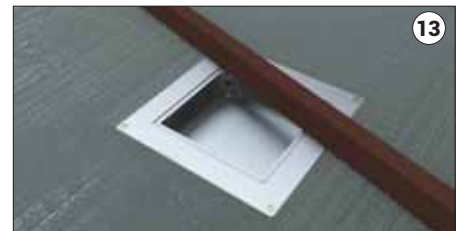
13 Son olarak nizami şapı dökünüz ve master ile önceden çekilmiş ip seviyesine getirerek, düzenleyiniz.
