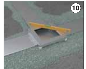
10 Tesviye şapını atınız. Buat ve kanal altındaki boşlukları tam olarak doldurunuz.
